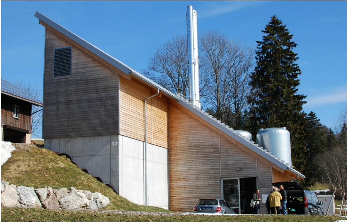
Abb. 14: Hackschnitzelfeuerungsanlage im Naturpark Südschwarzwald (Foto: E. MILZ)
