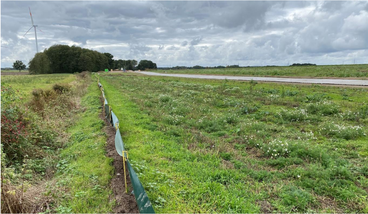
Abb. 11: Korrekte Aufstellung eines Amphibienschutzzauns. (Quelle: OECOS GmbH).
