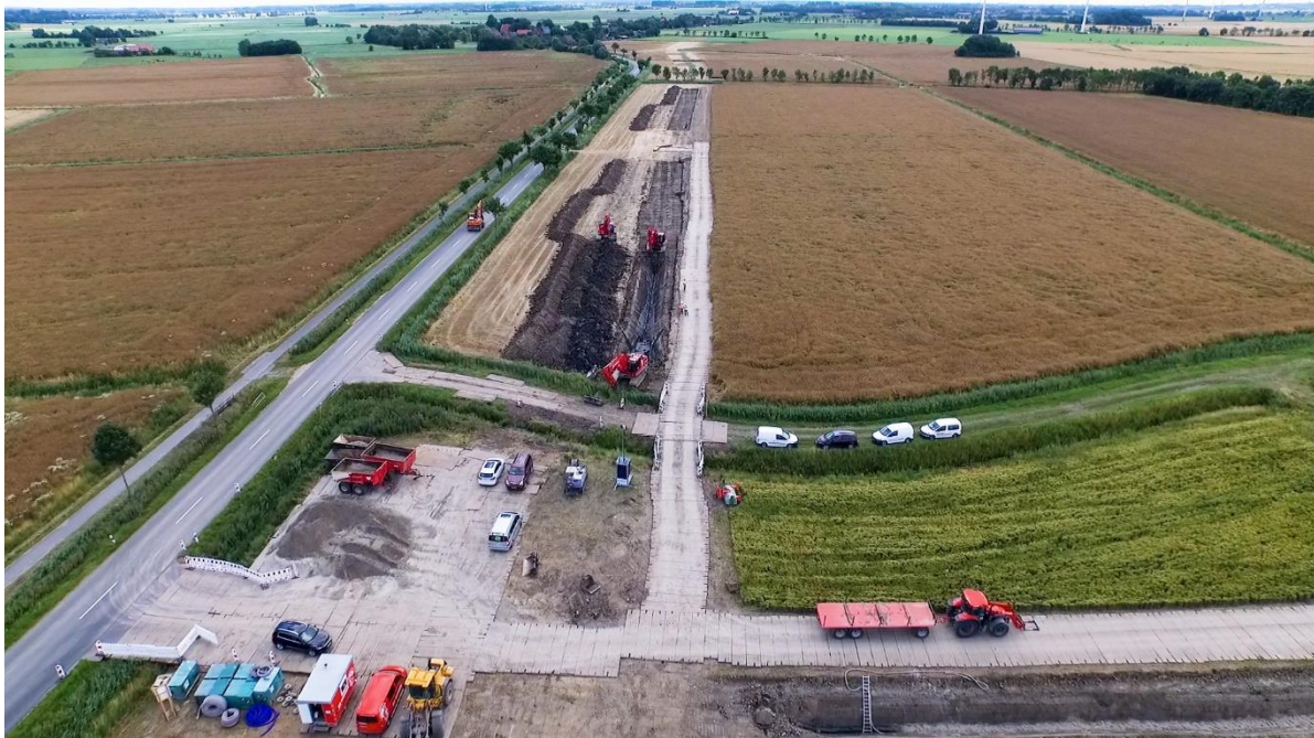
Abb. 4: Beispiel einer Gleichstrom-Erdkabelverlegung im Jahr 2015 im Projekt BorWin3.
