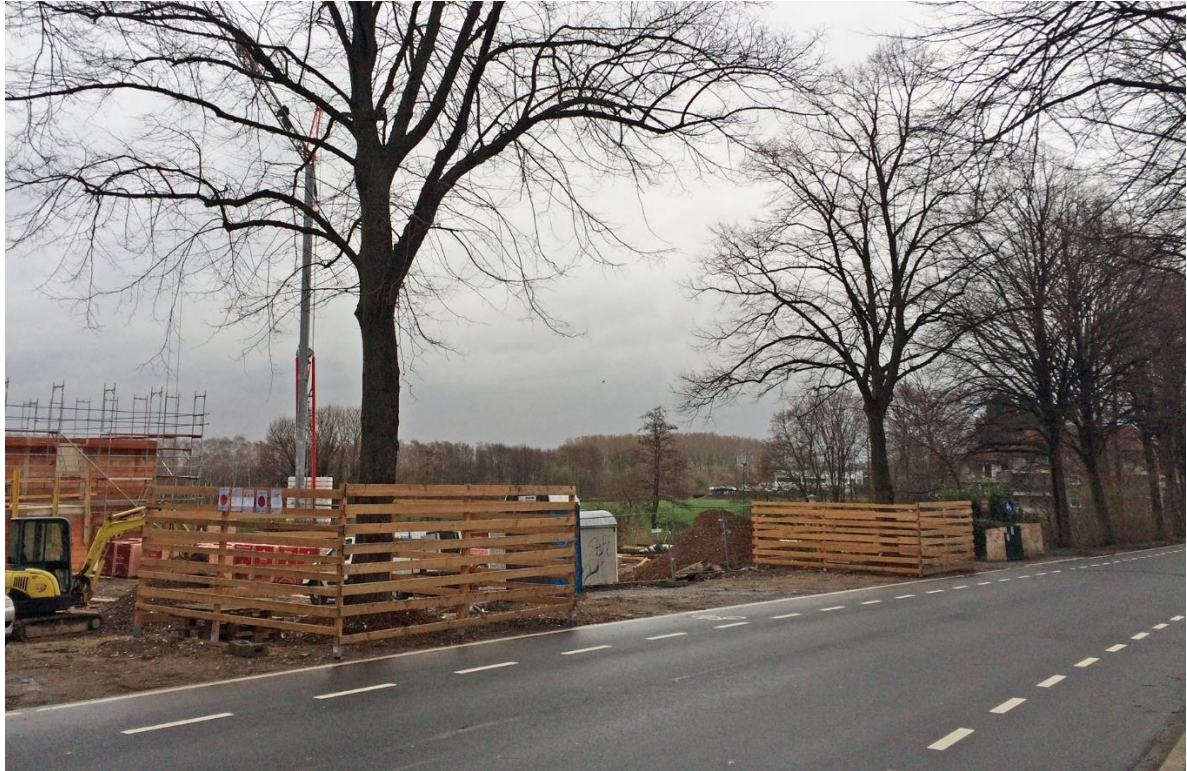
Abb. 12: Beispielhafte Errichtung von Schutzzäunen für Einzelbäume. (Quelle: Markus Streckenbach).
