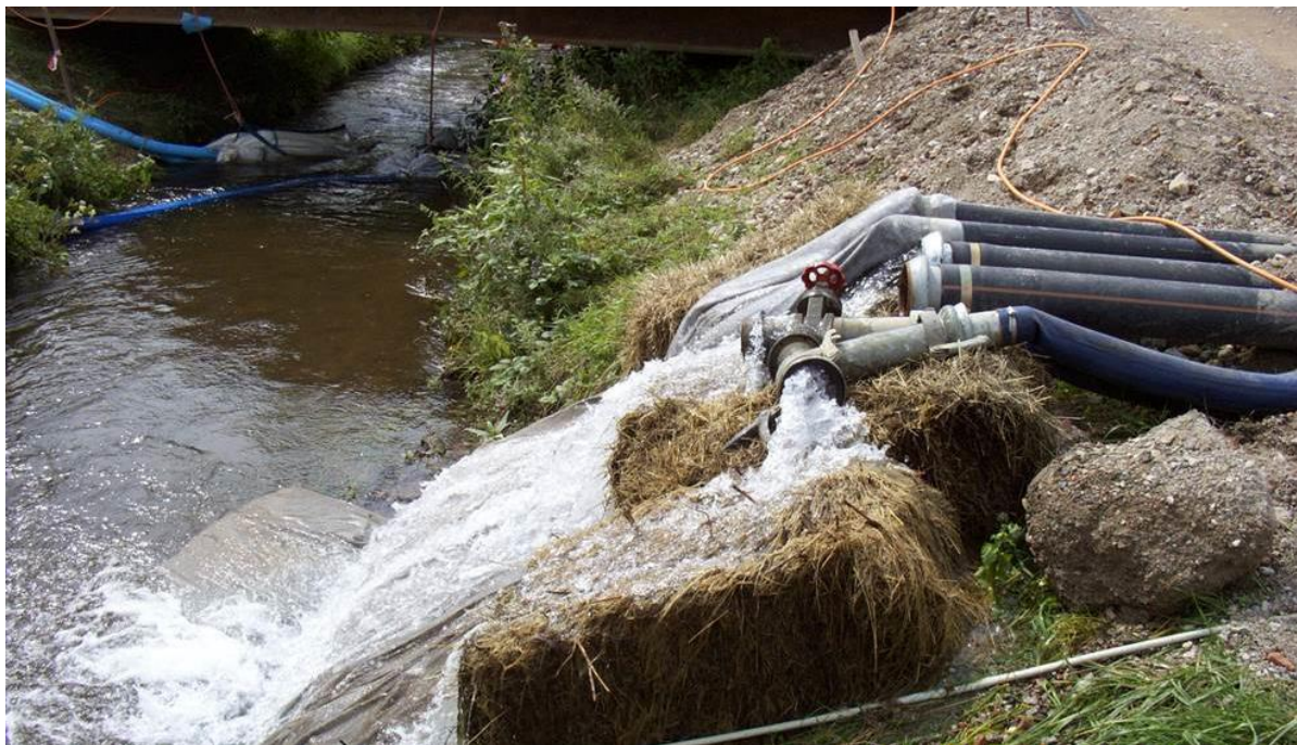
Abb. 14: Beispiel einer böschungsschonenden Bauwassereinleitung. (Quelle: IBNi Ingenieurbüro Nickel GmbH)
