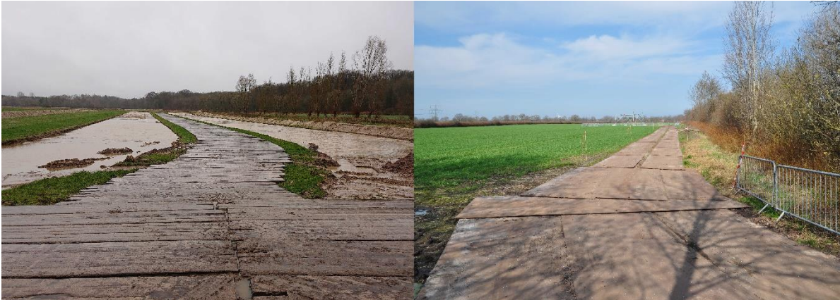
Abb. 8: Fahrbohlen aus Holz (li.) und Lastenverteilungsmatten aus Stahl (re.). (Quelle: Sarah Witte / LWK Niedersachsen (links); Dr. Marek Filipinski / LLUR (rechts)).
