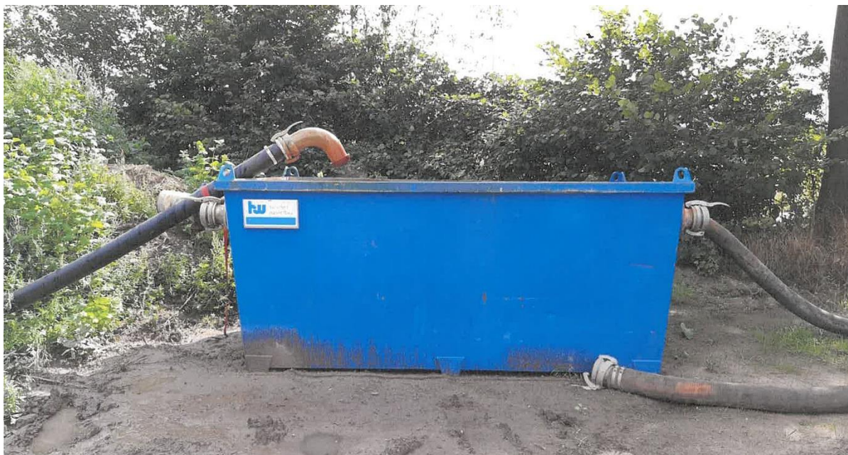
Abb. 13: Absetzbecken für Bauwasser.
