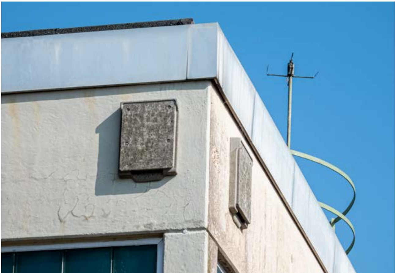
Fassadenkästen für Fledermäuse als vorgezogene Ausgleichsmaßnahme
