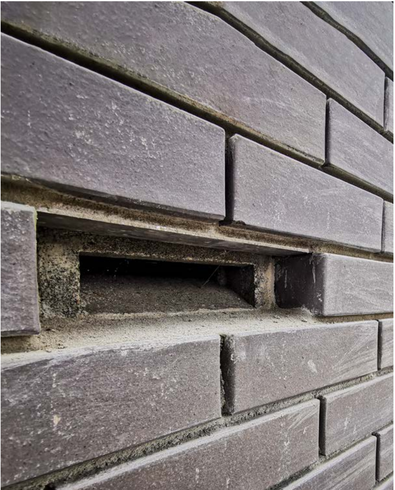
Nach Sanierung in Fassade eingelassene Fledermausquartiere
