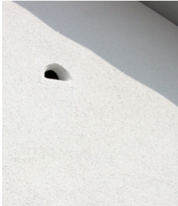
Abb. 2.12: Ersatzquartier für den Hausrotschwanz, Niststein „Typ 26“ (Fotos: Firma Schwegler)
