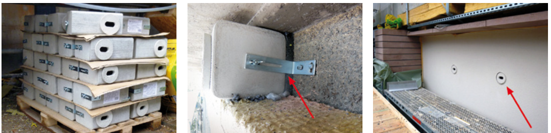
Abb. 2.9: Beispiele für die Anbringung von Nistkästen für Mauersegler (Fotos: Ingolf Grabow)
