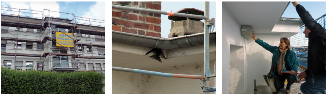
Abb. 2.3: Besiedlung durch Mauersegler. Anbringung von Nistkästen in Aufputz-Bauweise (Fotos: Immobilienverwaltung Steinkrug e. K., rechts, Stadt Offenbach)
